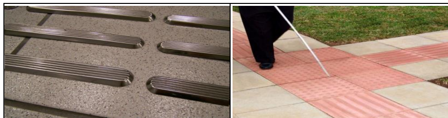
Figura 40: Piso tátil direcional em inox e a cerâmico antiderrapante
